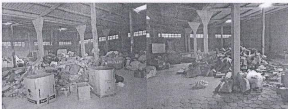
Figura 4-25 - Galpão de Triagem.
